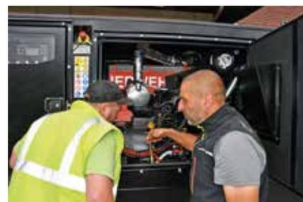
schaft der FF Stockenboi. Das Aggregat hat eine Dauerleistung von 63 kVA/50,4 kW.
