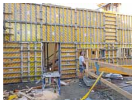
Aufgehendes Mauerwerk in Schalung
