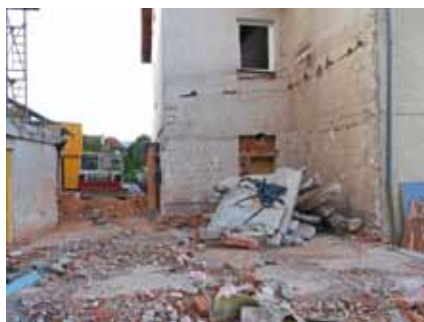
Nach dem Abbruch
